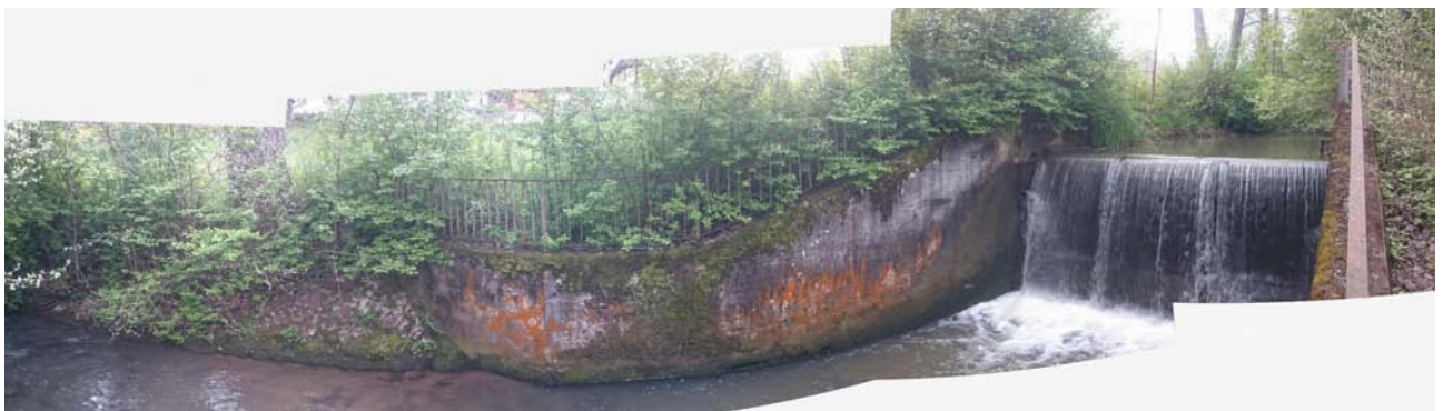
Wehranlage in der Waldach, die im Rahmen des Vorhabens teils zurückgebaut und durch eine Raue Rampe ersetzt wird. Das Foto zeigt die Wehranlage auf der Südostseite der Waldach im Bereich des Vorhabens
