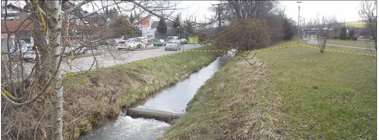
Ansicht aus Nordwesten auf die Vorhabensfläche.
