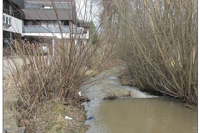
Sohlschwelle in der Waldach im Bereich des Vorhabens
