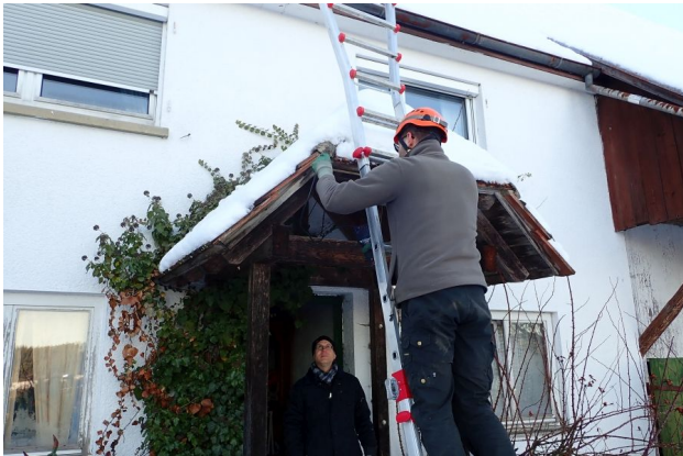
Abb. 24: Ein Hohlraum unter dem Vordach wird endoskopiert.
