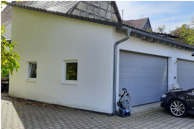
Abb. 7: Garage (Blick aus nördöstlicher Richtung).
