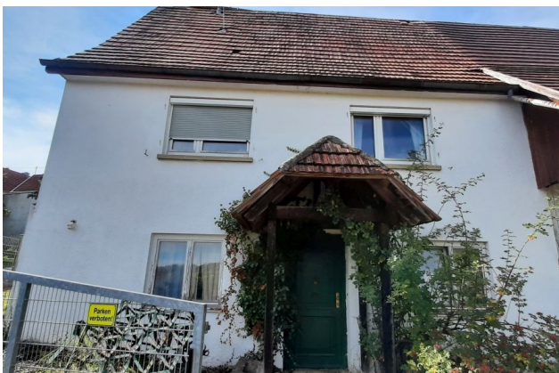
Abb. 5: Leerstehendes Wohngebäude (Blick aus östlicher Richtung).
