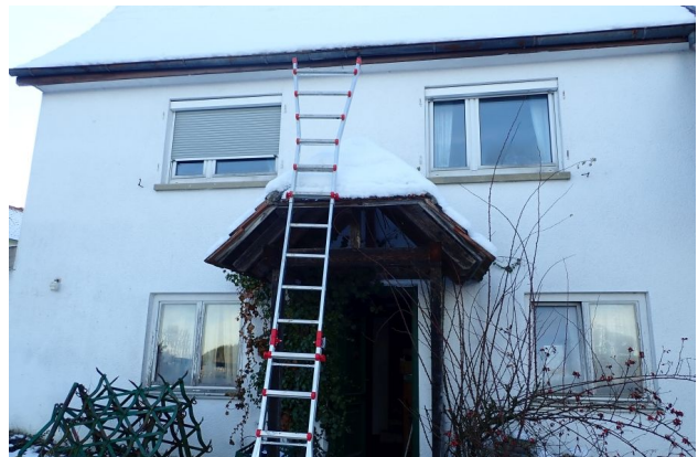
Abb. 29: Auch an der östlichen Seite des Gebäudes waren keine Schwalbennester zu finden.
