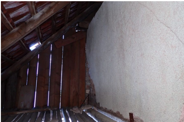
Abb. 22: Blick in den Anbau ohne Hinweise auf ein Quartierpotenzial für Fledermäuse.
