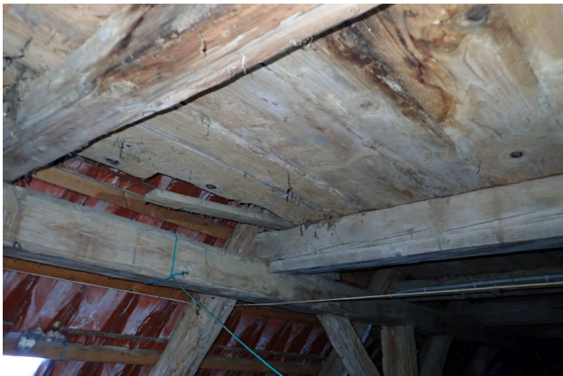
Abb. 16: Decke zwischen dem ersten und zweiten Stockwerk des Dachbodens
