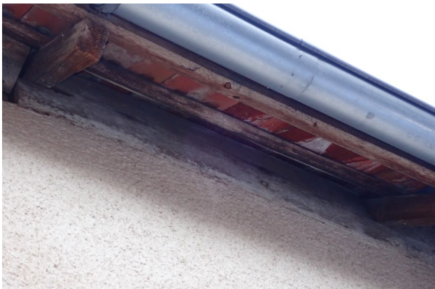
Abb. 28: Unter dem Dach befanden sich keine Schwalbennester.
