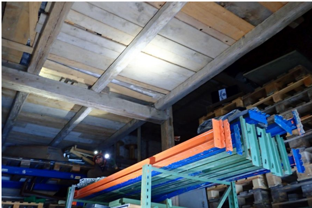
Abb. 20: Innenraum der Scheune
