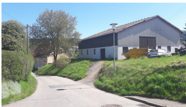
Abbildung 5: ehemaliges landwirtschaftliches Gebäude auf Flurstück Nr. 284, das erhalten bleibt, mit Zufahrt von der Häfnergasse
