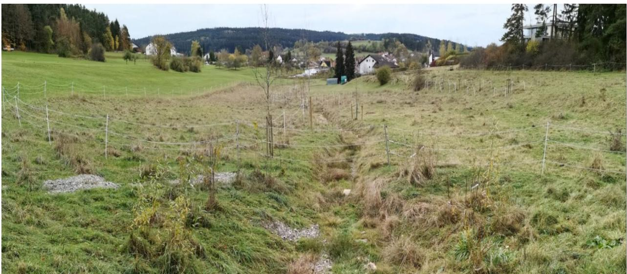
Abb. 5: Geöffneter Wiesengraben mit geschwungenem Verlauf im Senkenbereich der Weidefläche.
