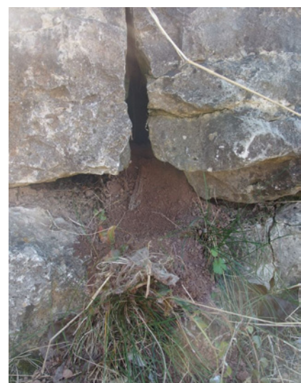
Abb. 12: Spaltenbereiche in der nördlich gelegenen Natursteinmauer mit hintergrabbarem Material.
