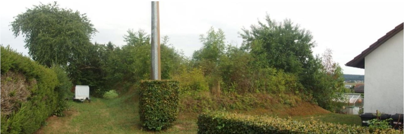
Abb. 4: Erhöhter Wasserhochbehälter auf dem Flurstück Nr. 219 mit dichtem, verbrachendem Gehölzaufwuchs.
