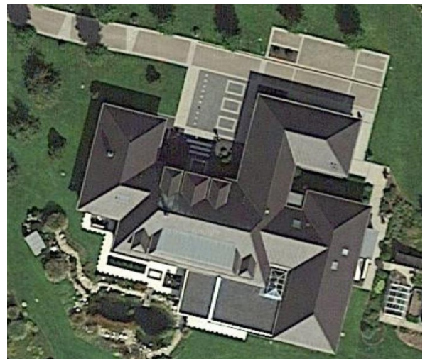
Abb. 7-1: Prüfung PV-Eignung Dachflächen
