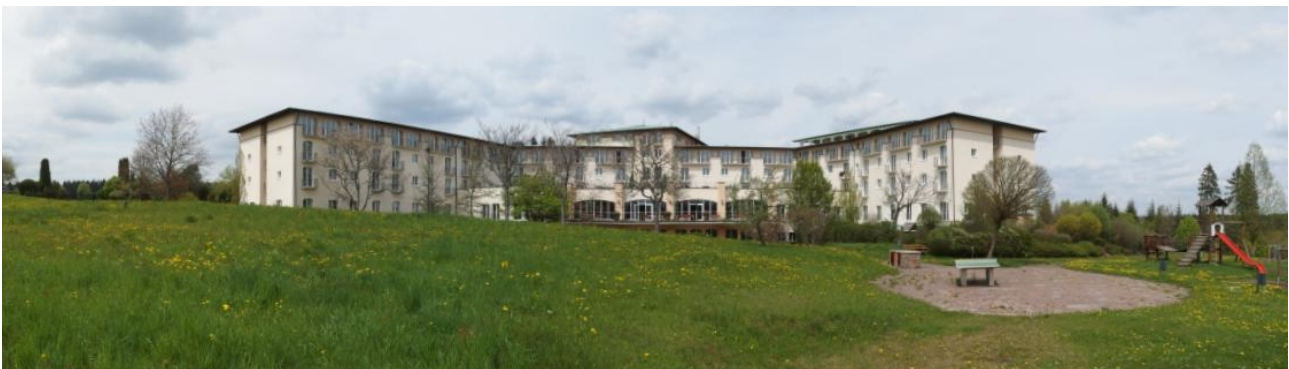
Abb. 4: Überblick über das Klinikgebäude und die südlich vorgelagerten Außenanlagen inklusive Spielgeräten für Kinder.
