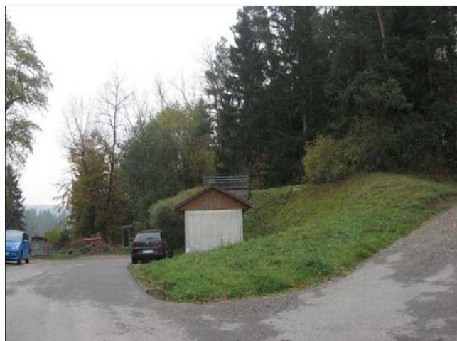
Blick in Richtung Norden auf Wasserhochbehälter
