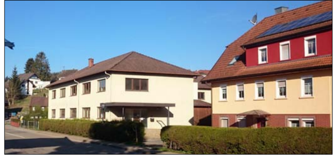
Ansicht von der Waldachstraße aus auf das Plangebiet
